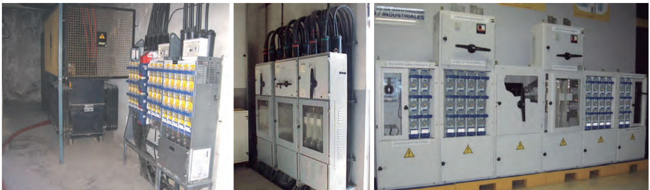
Algunos ejemplos de cuadros de distribución instalados / Some samples of installed LV-panels
