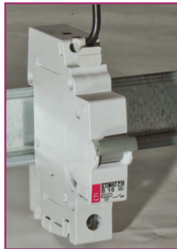
Conexión del cable Connecting the wire
