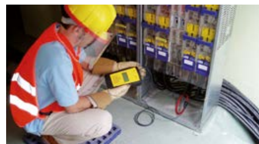
Identificación de cable con el receptor Ariadna IC1G-RX.
