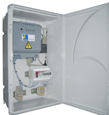
Envolvente tamaño L CMBT Telegestión Telemetering CMBT large enclosure
