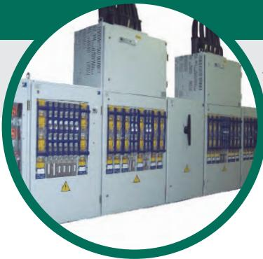
Cuadro General de fábrica formado por diferentes CBTAs de 8 huecos: 2 acometidas con interruptor automático de 2500 A, un módulo de interconexión, 2 módulos de ampliación del nº de salidas con bases tripolares BTVC y 2 cuadros con bases unipolares NH para 1 salida de hasta 1600 A.
