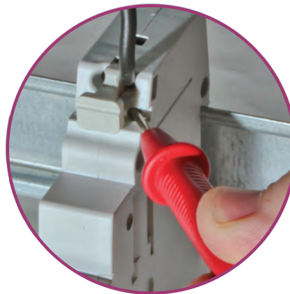
Comprobación de tensión Voltage test
