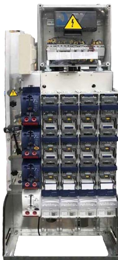
El **Cuadro de Baja Tensión Compacto** es el encargado de repartir la salida del transformador en un número de salidas protegidas e independientes (mediante bases portafusibles TRIVER+) para la red de distribución de Baja Tensión.
