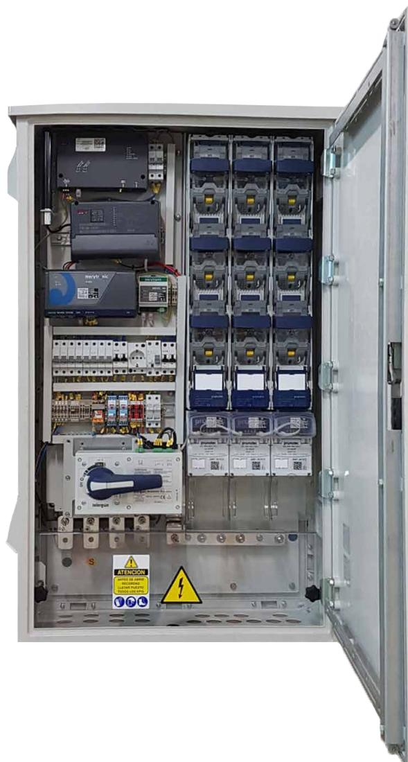
El **Cuadro de Baja Tensión Intemperie de Telegestión (CBTI-T)** es el encargado de repartir la salida del transformador en un número de salidas (3) protegidas e independientes hacia la Red de BT (mediante bases portafusibles TRIVER+).
