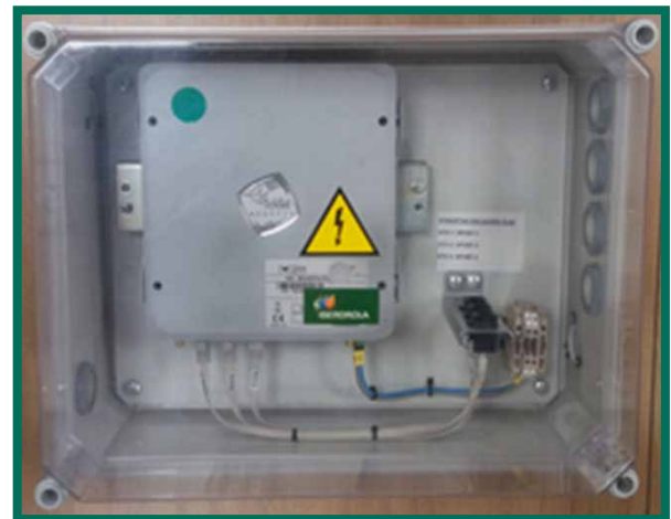
ARMARIO CON EQUIPO INSTALADO
