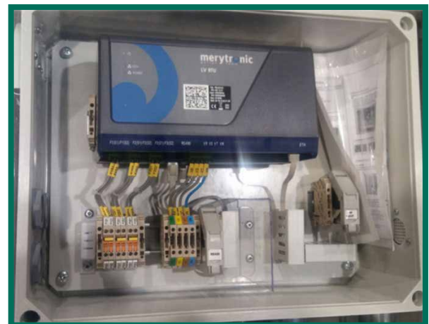
ARMARIO CON EQUIPO INSTALADO
