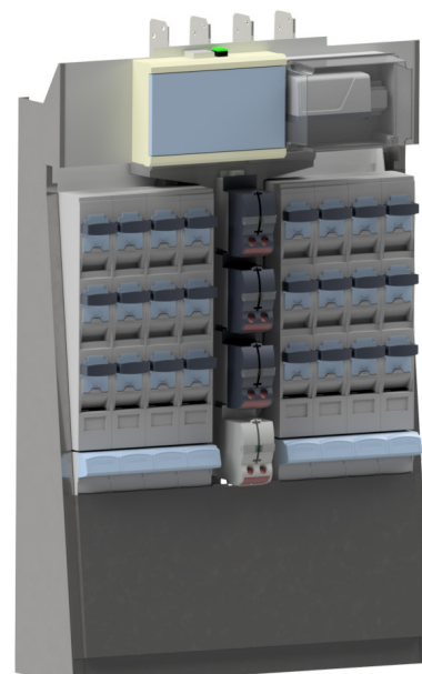
Envoltente, acometida superior con SIC, 8 salidas y SAL inferior para monitorización.
